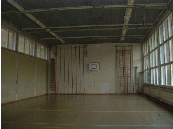
Bestehende Turnhalle mit sehr tiefem Beleuchtungsniveau
